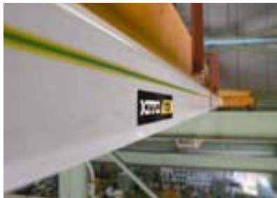
横行給電施工例
