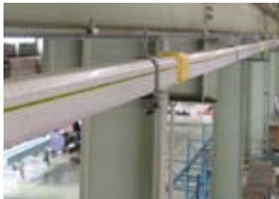
走行給電施工例
